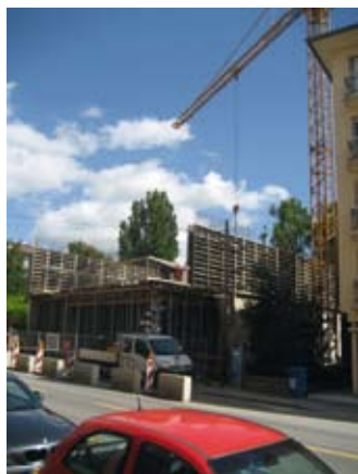
En construction : le nouveau siège ALIAI / OAI 4, boulevard Grande-Duchesse Charlotte à Luxembourg
