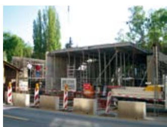
En construction : le nouveau siège ALIAI / OAI
