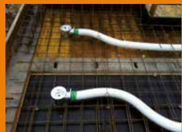
Pose des tuyaux de ventilation dans une dalle
