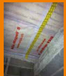
Etanchéité à l'air au niveau toiture
