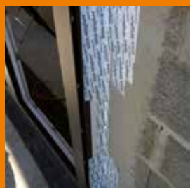
Montage RAL (étanche à l'air) des fenêtres
